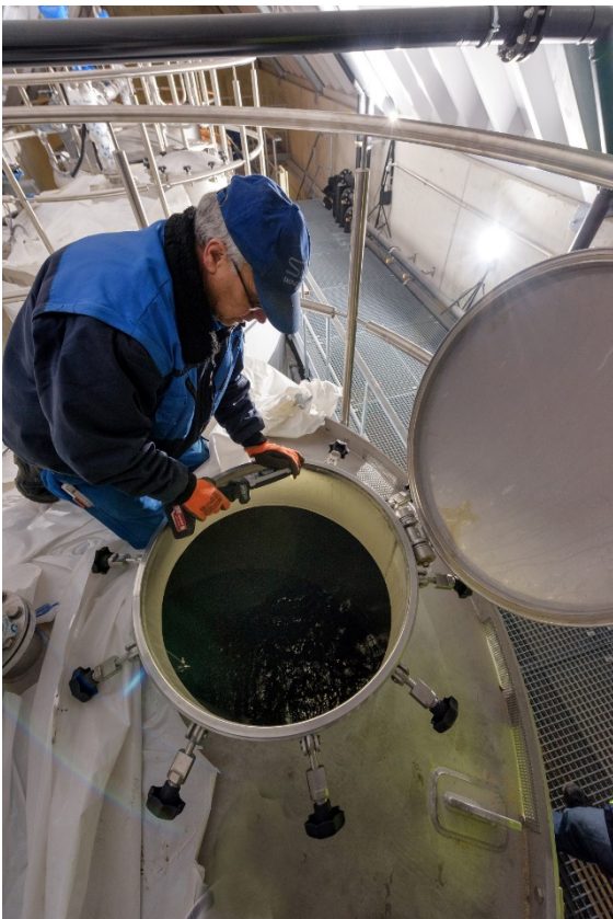
Bild 11: Aktivkohlebefüllung im Wasserwerk Rauental – die Entfernung von PFC aus dem Wasser funktioniert am effektivsten und effizientesten über das Adsorptionsverfahren mit Aktivkohle. Bildnachweis: Stadtwerke Rastatt, Oliver Hurst
