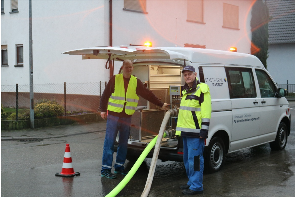
Bild 1: Das Spülmobil der Stadtwerke Rastatt zum Reinigen von Wasserleitungen. Bildnachweis: Stadtwerke Rastatt, Maria Philipps
