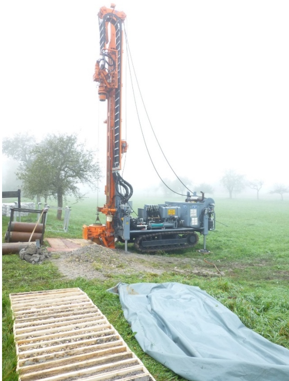
Bild 4: Messstellenbohrung im Vorfeld vom Wasserwerk Ottersdorf. Bildnachweis: Stadtwerke Rastatt, TZW: DVGW-Technologiezentrum Wasser
